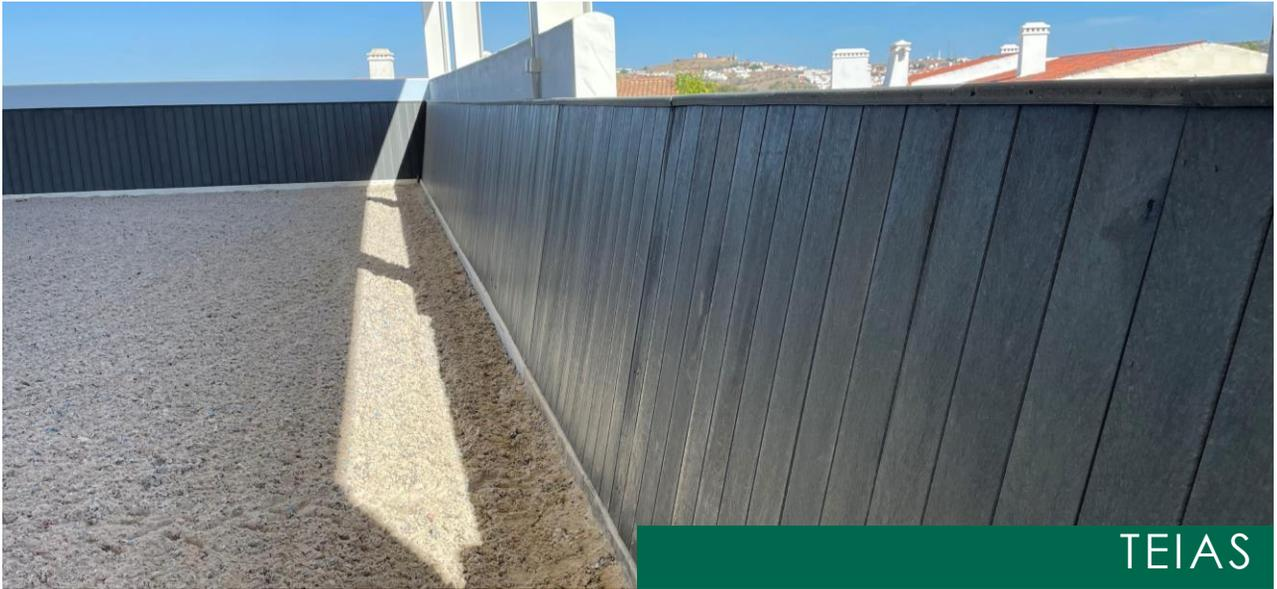
A teia é uma estrutura fundamental num picadeiro quer coberto quer descoberto. Esta estrutura consiste no revestimento das paredes em volta da arena, revestimento esse que deverá ser de materiais resistentes a pancadas e ao desgaste pelos anos. Esta assume um papel importante no que respeita à segurança do cavaleiro e do cavalo, pois evita que ambos toquem e raspem na parede evitando possíveis acidentes.
